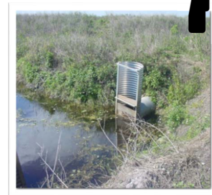
Descarga lenta de zanjas cercanas a la estructura de descarga
