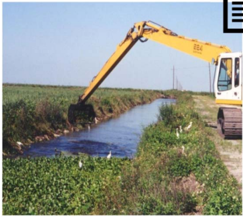
Limpieza de sedimentos en canales y zanjas (No descarga. Disposición de lodos)
