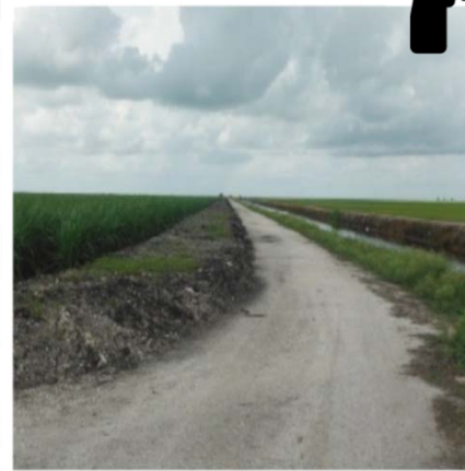
Vegetación o bermas en los bancos de los canales
